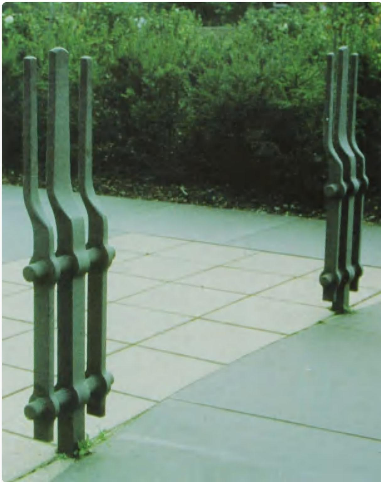
Alan Evans 在邱公共档案馆制作的系缆柱。重型杆材上的阶梯式锥度,采用冲孔和铆接连接。
