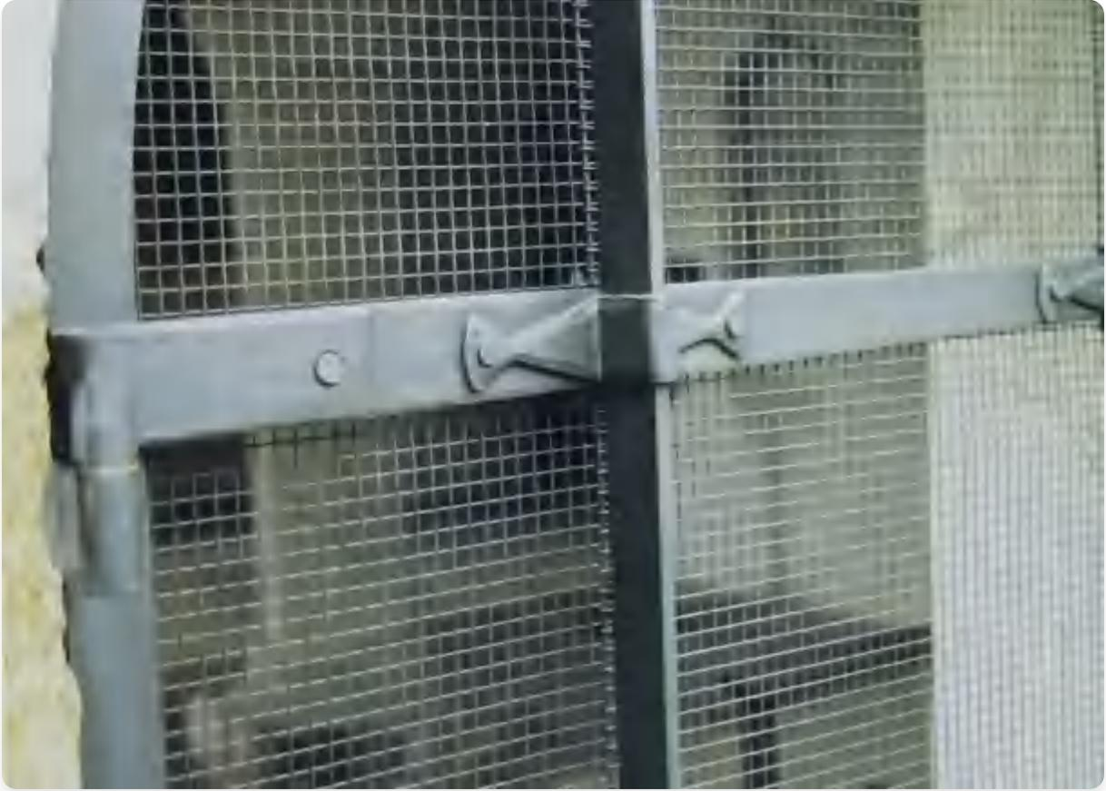
作者制作的门的细节，根据样板制作（对页）。门采用不锈钢网，允许空气进入未加热的建筑物，但紧密贴合拱门以防止鸟类进入。
