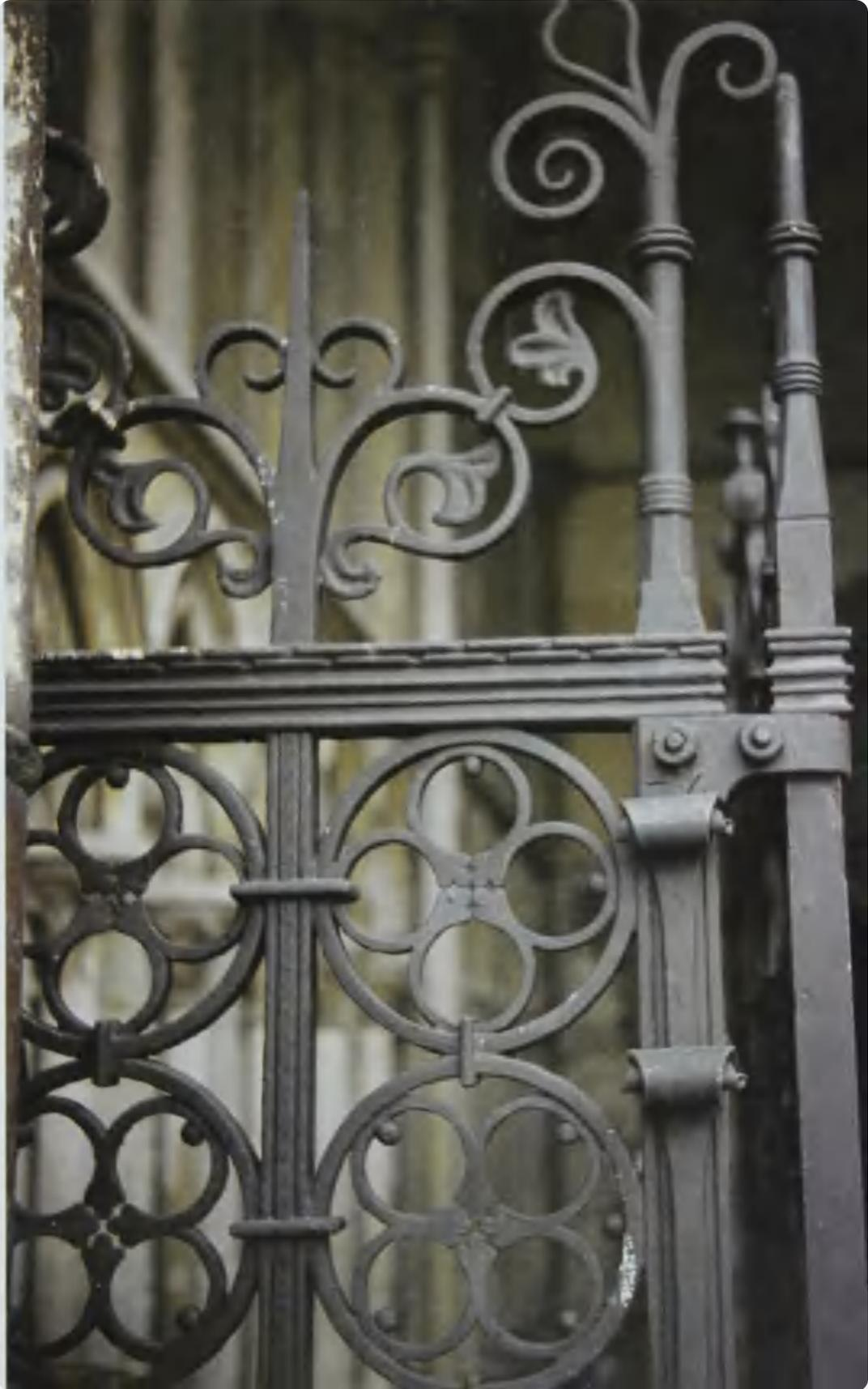
索尔兹伯里大教堂的一扇门，展示了重复图案的使用，并说明了在水平横梁上使用凹槽(fullering)和在竖杆上应用钢条的视觉手法来减少钢条的视觉厚度
