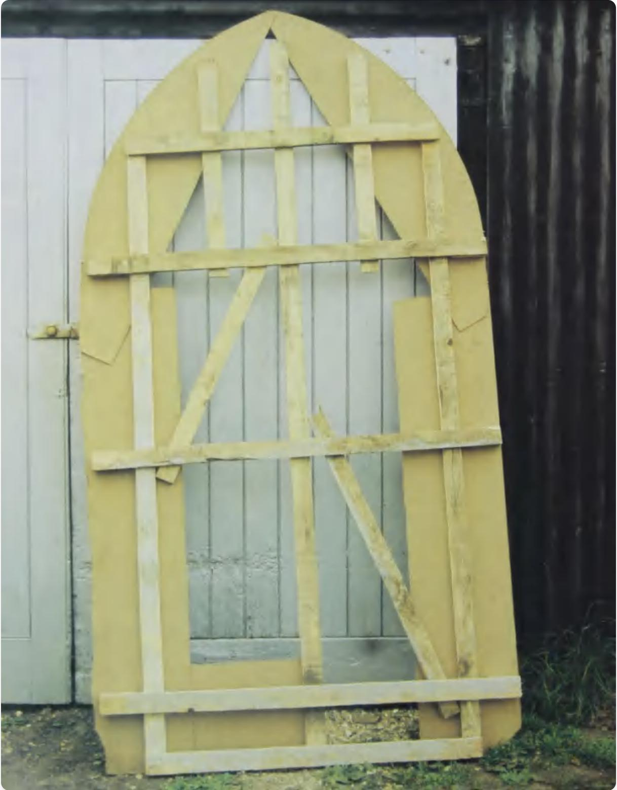
在现场制作的大型木材和硬纸板样板，用于确定教堂石拱门的轮廓。
