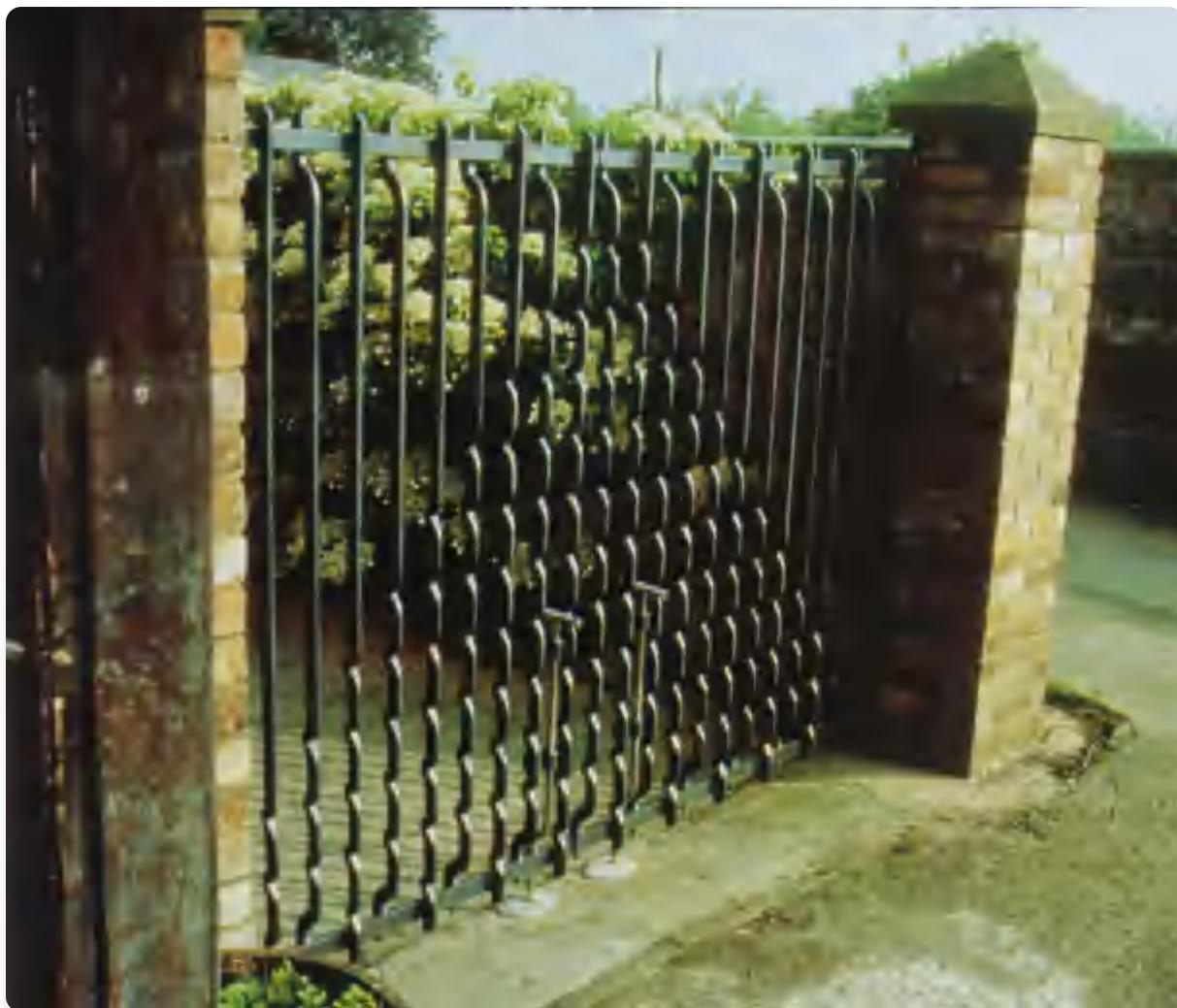
*Alan Evans设计的入口大门。弯曲的装饰图案是通过将圆凿(fuller)打入支撑在型砧上的杆件实现的。*
