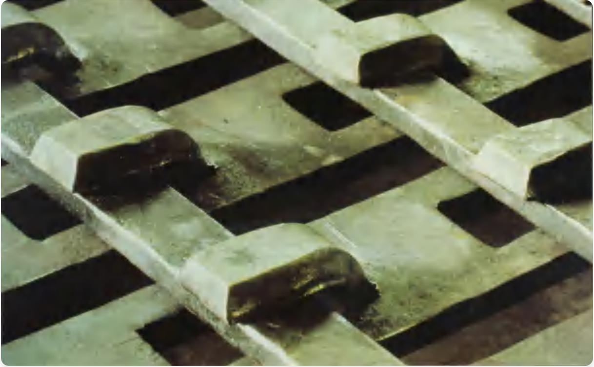
*Jim Horrobin为V&A博物馆制作的门的热切榫头结构细节。每个榫头最后都铆接到另一根钢条上。*
