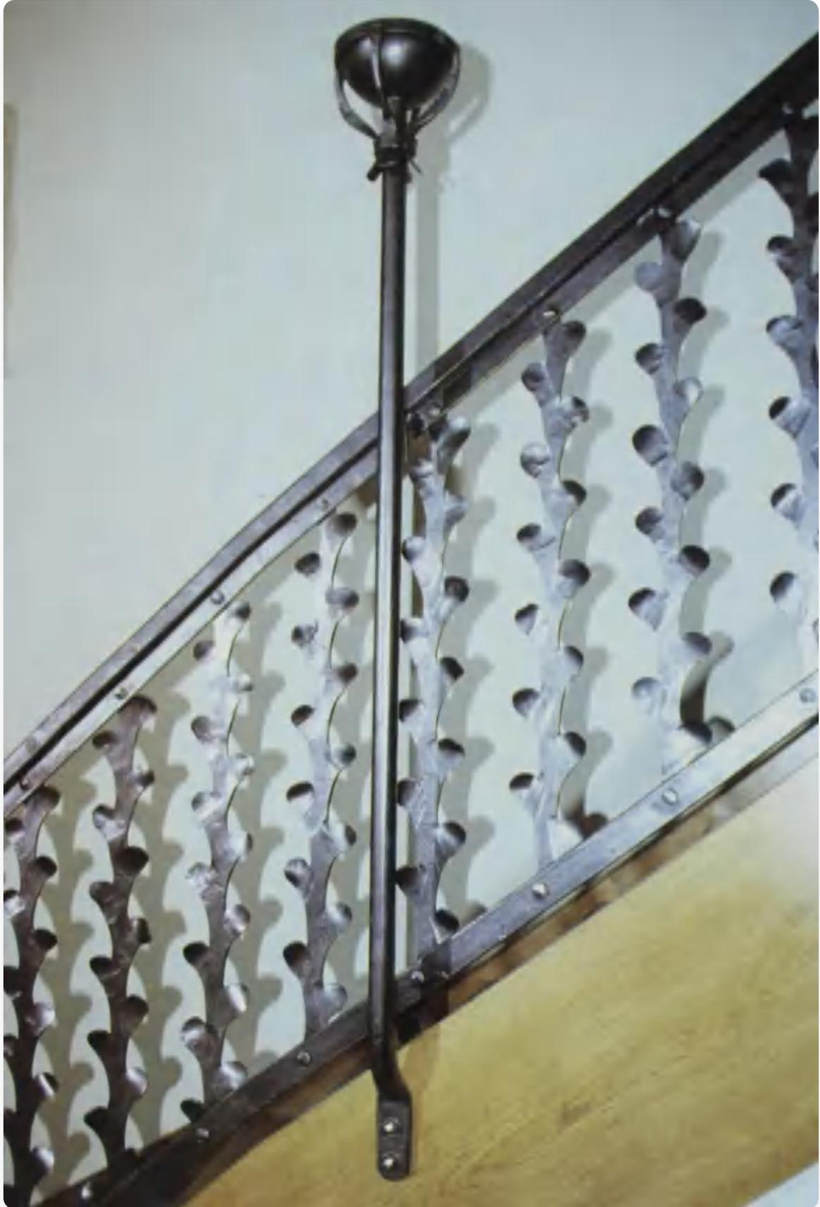
*Charles Normandale*设计的由重复单元组成的栏杆。每个单元先激光切割后锻造,锻造在设计中提供了一些变化,同时也满足英国建筑规范要求,即100毫米(4英寸)的球体不能穿过。
