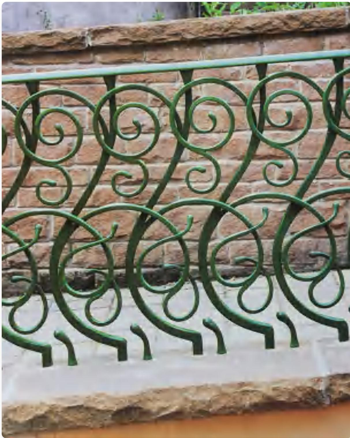
Brian Russell在彭里斯的栏杆部分。弯曲每个单元需要几个夹具(jig)。这是重复单元产生的丰富图案的例子。每个单元之间从地面铺装中冒出的微小“芽”是为了填充空间，以符合英国建筑法规，该法规要求为保护坠落,直径100mm(4英寸)的球不能穿过栏杆。
